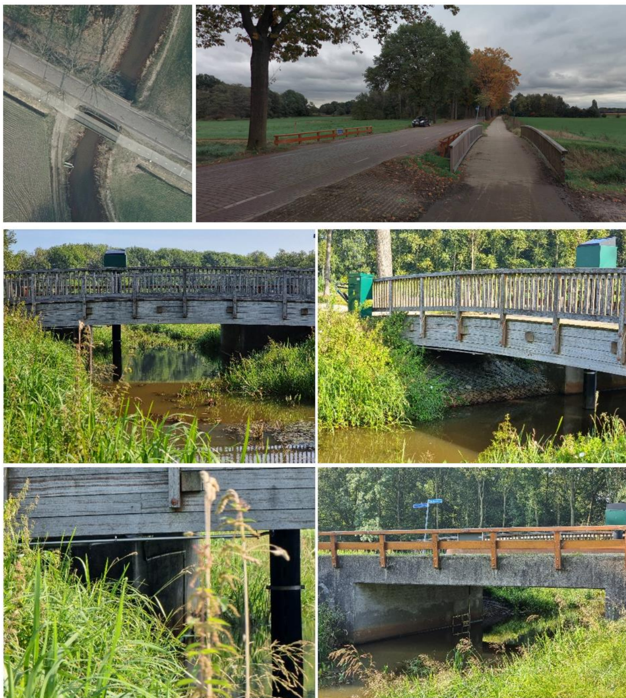
Figuur 1.5-20 Huidige situatie brug De Hoeve
